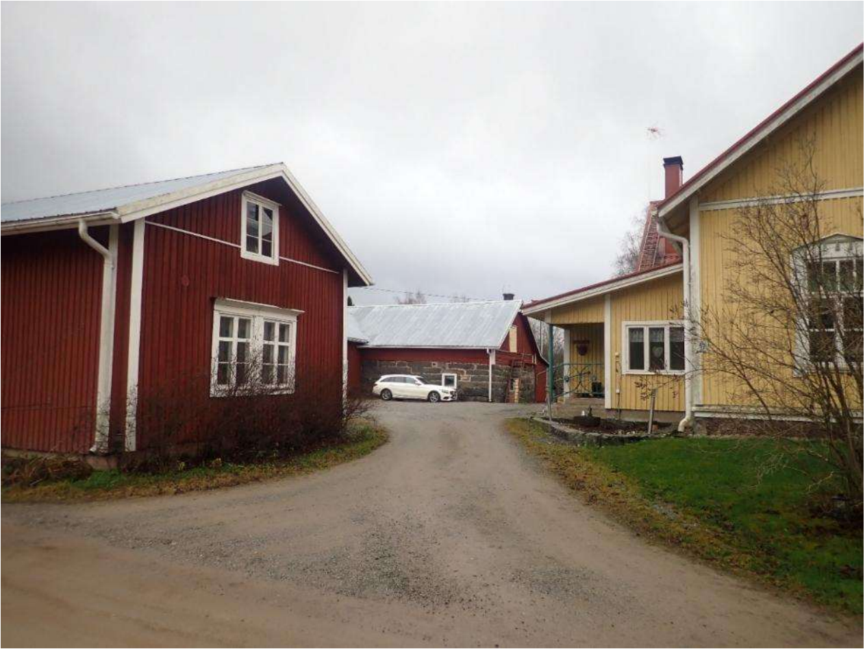
Kuva 41. Vainionpään tilan pihapiiriä. Etelään.
