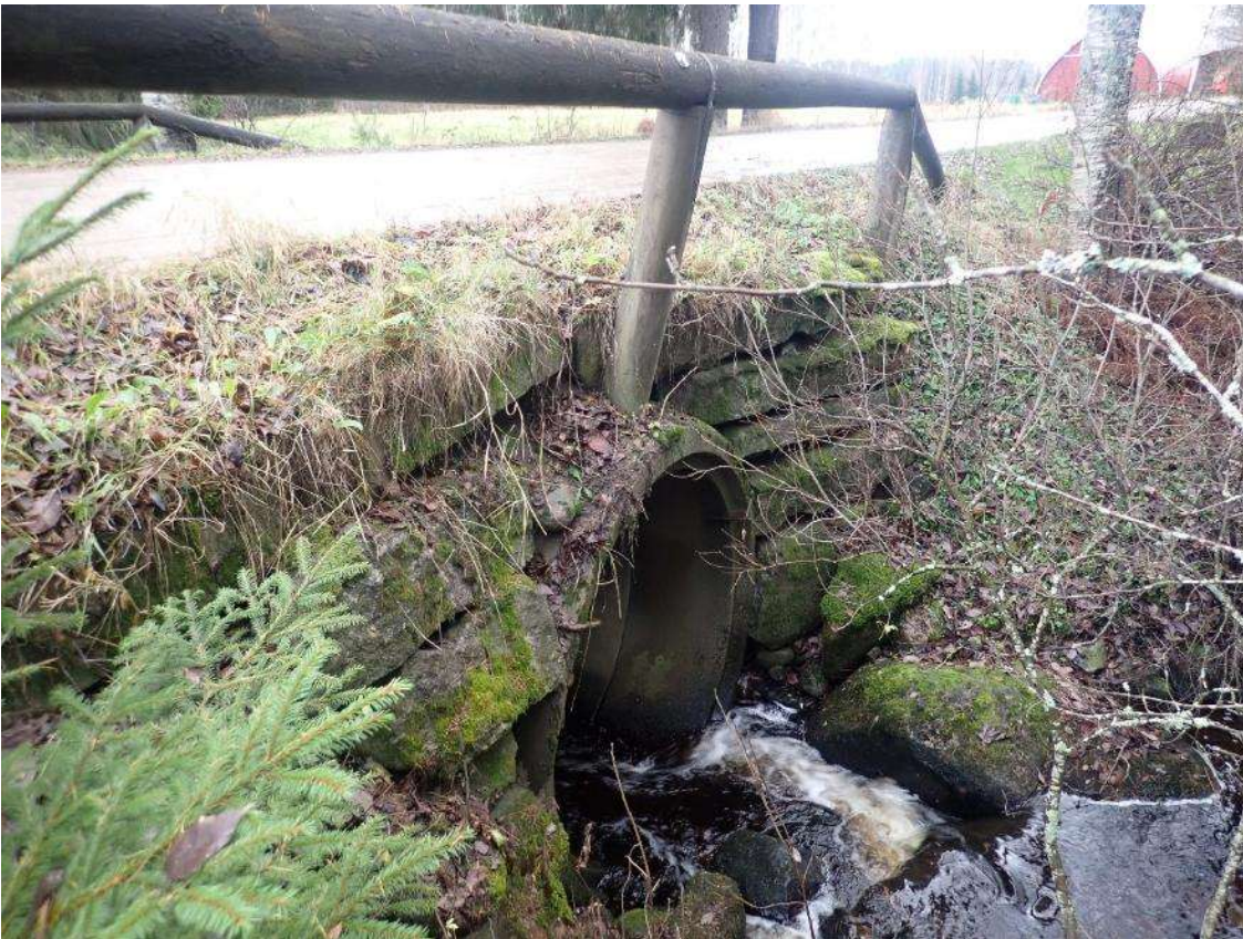
Kuva 39. Sillan alla oleva betonirumpu sekä lohkokiviä. Koilliseen.
