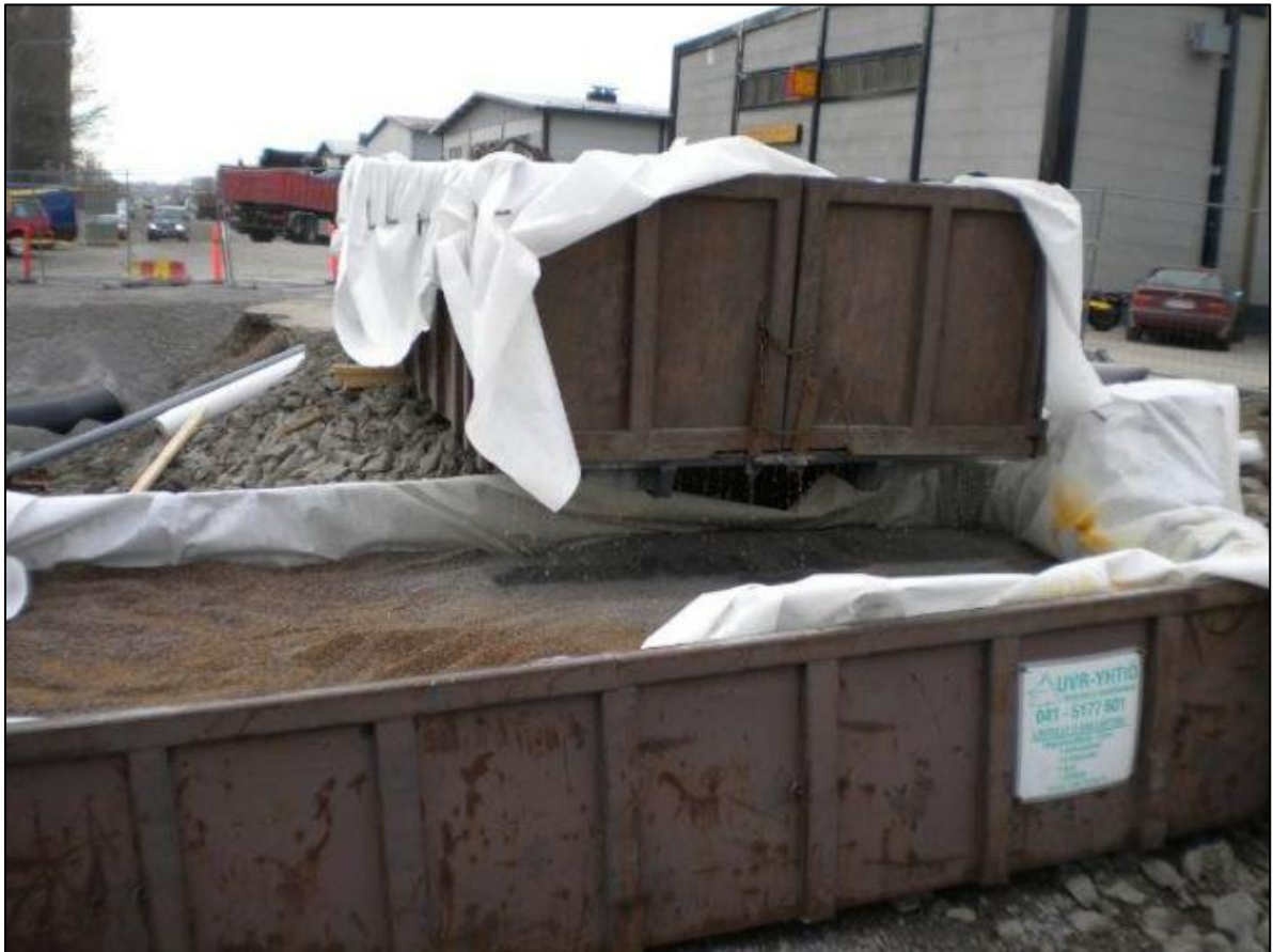
Kuva 15. Esimerkkikuva vaihtolavan sisään rakennetusta suodattimesta. 8
