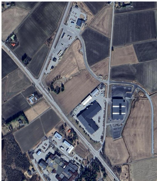
Kuva 11 Ortokuva kaavan muutosalueesta. Kuvassa keskellä sijainneen ent. maatalan rakennuskanta on purettu. Pihasta pihapuut ovat jäljellä. (kuva Google Maps)
