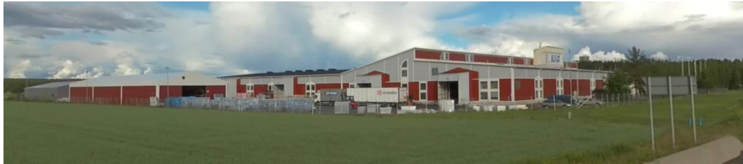
Kuva 8 Olemassa oleva teollisuushalli (Koja Oy)(kuva Google Maps, Street View)
