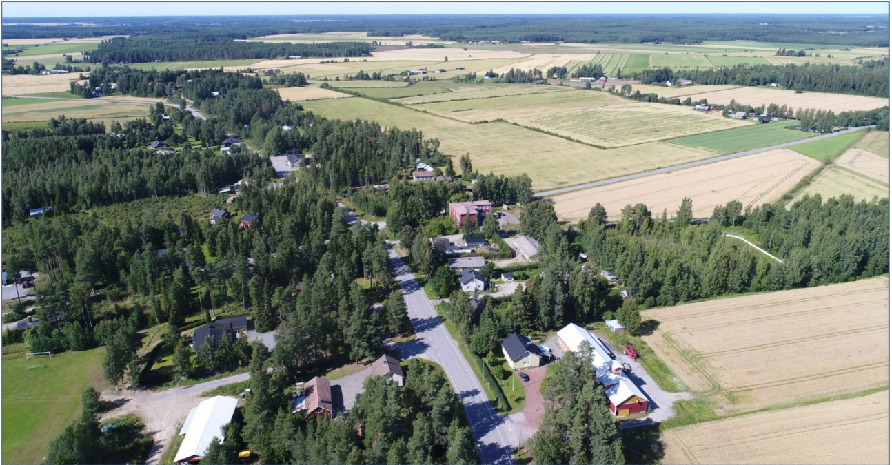
Kuva 25. Horonkylä. Viistoilmakuva kaakosta päin kuvattuna. Horontien varren rakennuskantaa sekä rakentamista reunustavia peltoalueita. Puuston ja pensaiden reunustama Lillän/Itäjoki erottuu kuvan yläosassa. © Plandea
