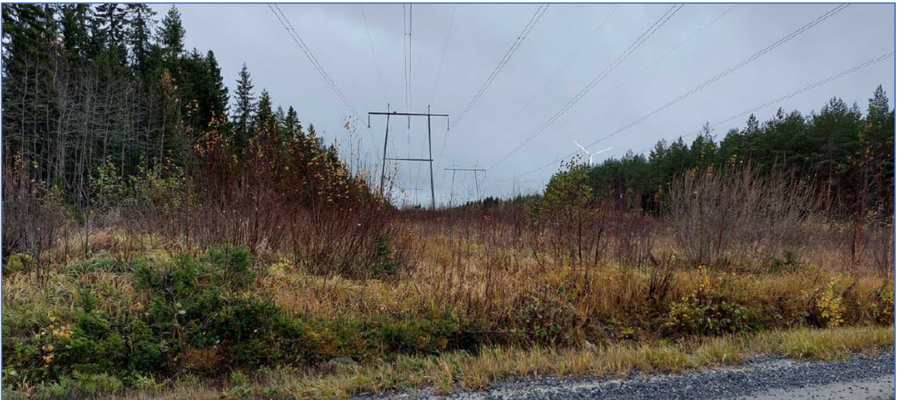
Kuva 43. Havainnekuva Närvijointieltä Teuvan ja Kurikan kuntarajalta (Kivistön esihistoriallinen alue), missä lähimpään voimalaan matkaa n. 2300m. © Envineer
