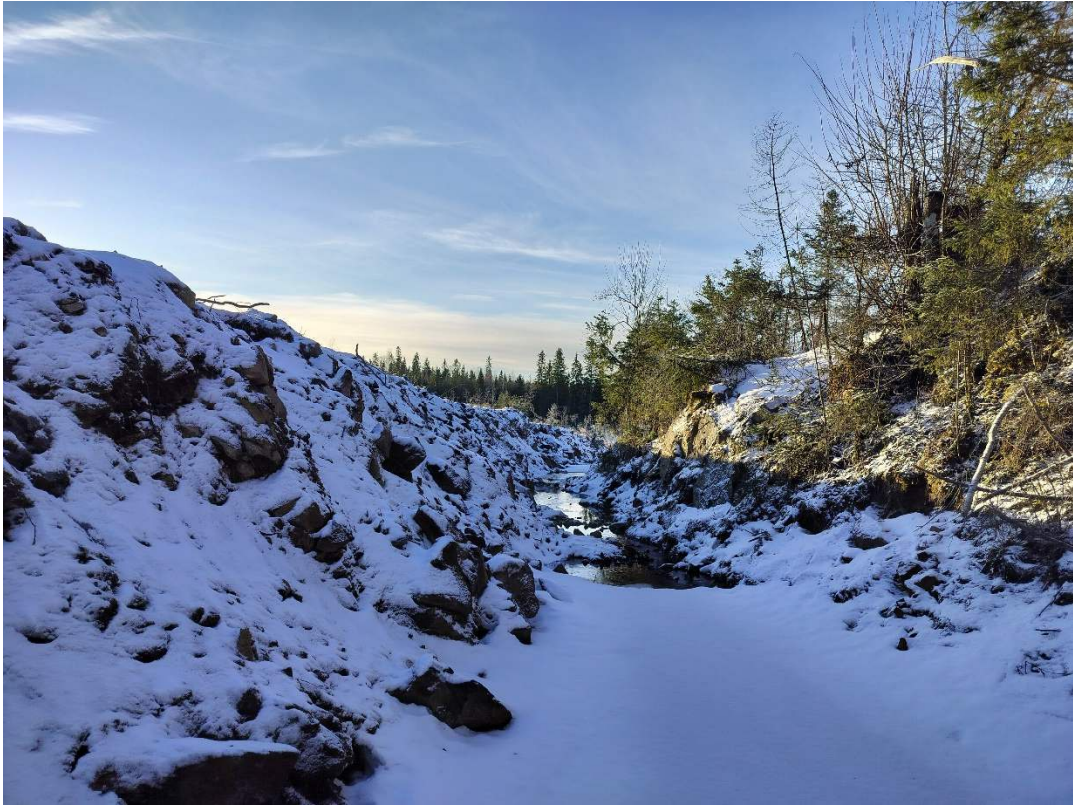
Kuva 13. Nykyinen ojasto mihin vedet pumpataan.
