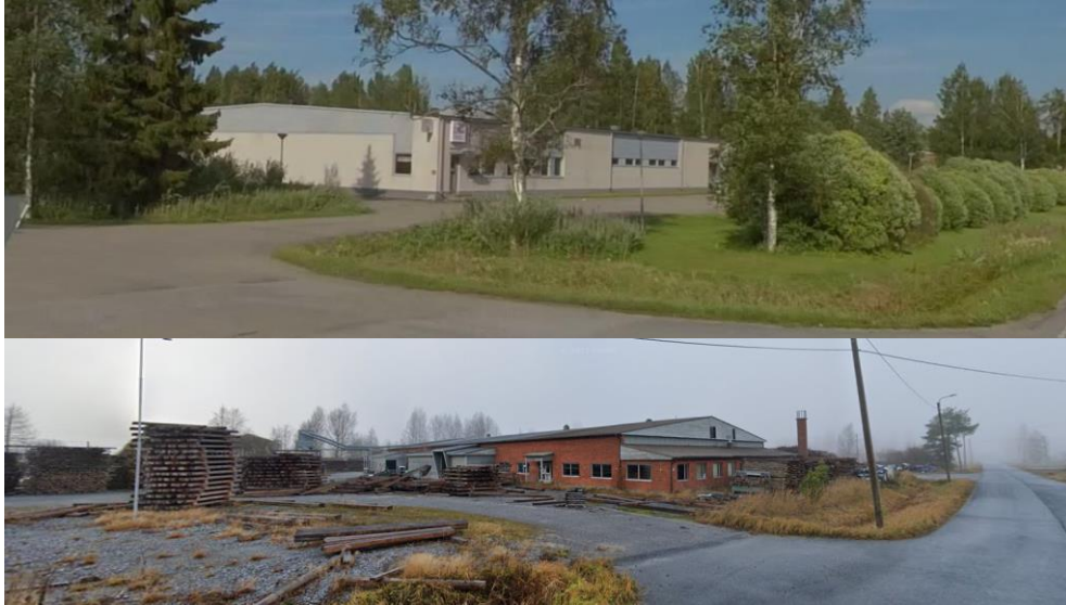
Kuva 10 Teollisuusrakennus Salontien ja Jurvantien kulmauksessa.
