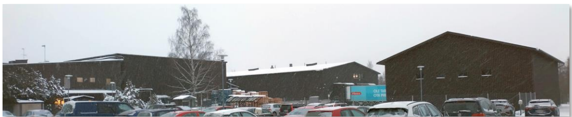
Kuva 13 Juustoportin meijerin rakennuskantaa.
