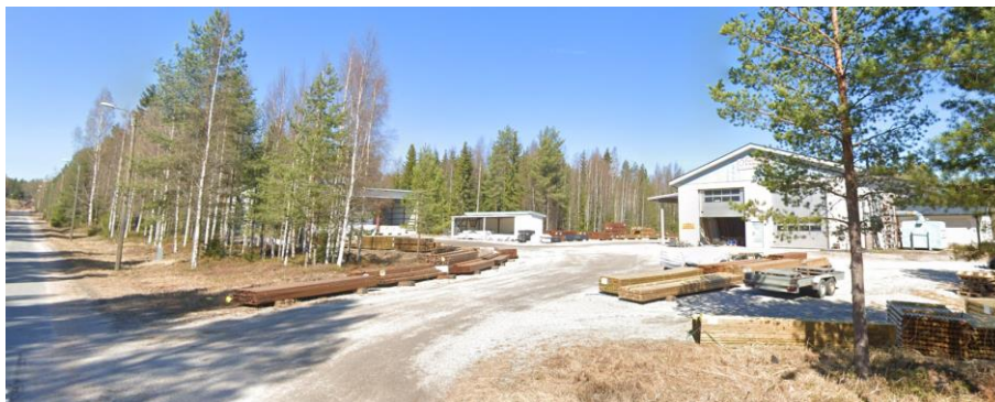
Kuva 10 Rakennus, Värkkitie 1 (Google Street View)
