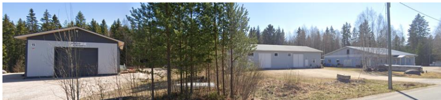
Kuva 9 Rakennukset, Verstastie 11-15 (Google Street View)
