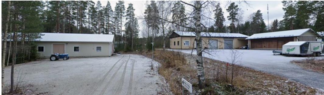
Kuva 9 Rakennukset, Yhteislaidun 20-22. (Google Street View)
