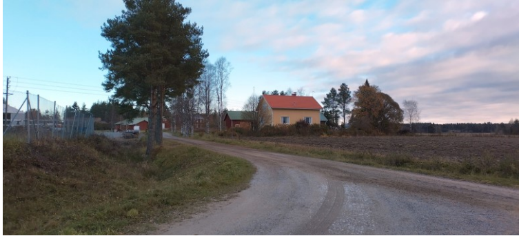
Hernesluhdantie 139. Jälleenrakennuskauden asuinrakennus.
