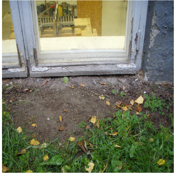
maantasossa oleva ikkuna rak. Päädyssä
