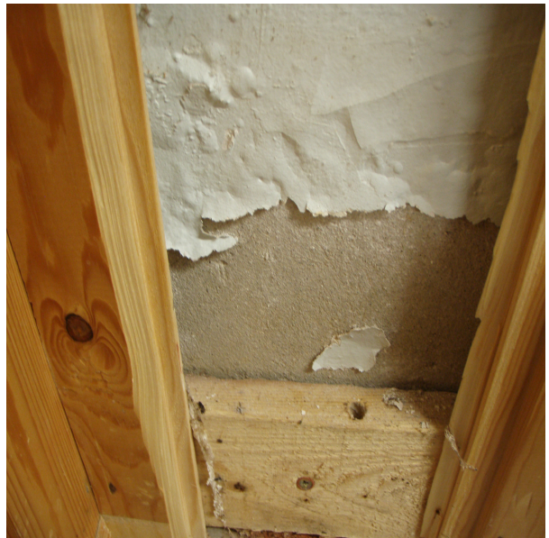
märkä seinä tekn.työn paneloinnin takana
