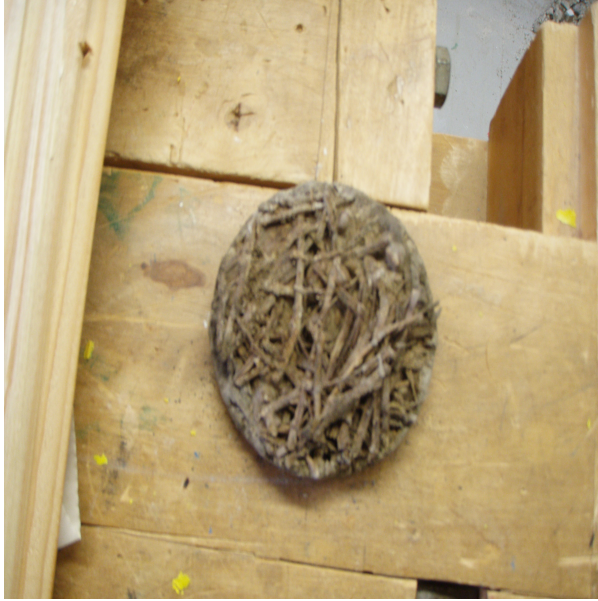
tuhoutunut Tojax-levy lattian alta
