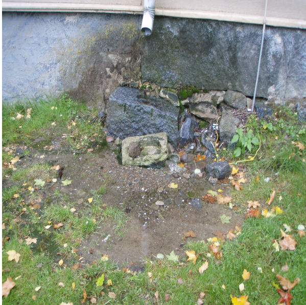
takapihan sadevesien ohjaus puuttuu
