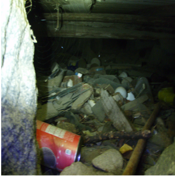
orgaanista jätettä alapohjassa
