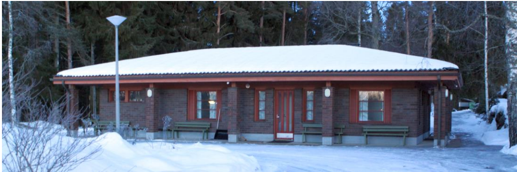
Kuva 13 Kuva hautausmaan aumakattoisesta ja tiilverhoillusta huoltorakennuksesta, joka on valmistunut 1970-80 luvun vaihteessa.
