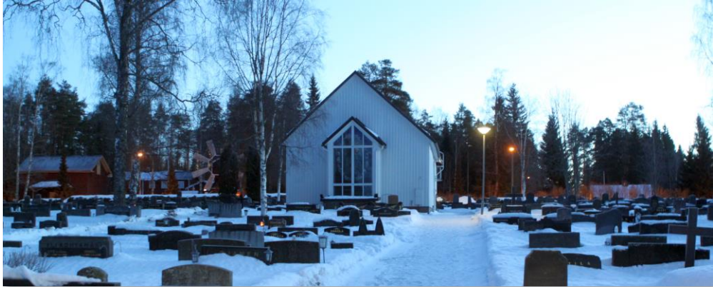
Kuva 10 Kuva siunauskappelista. Rakennus tehtiin 1952 arkkitehti E. Teräsvirran piirustuksien mukaisesti kappeliksi, jota parannettiin 1960 luvulla ja vuonna 1976 rakennusta laajennettiin. Altari ja muita järjestelyitä tehtiin vuonna 1997.
