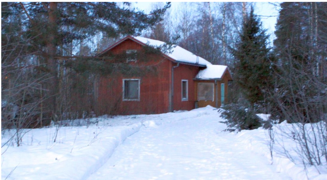
Kuva 14 Kuvassa yksikerroksinen puurakenteinen 40 neliöinen talo, joka on valmistunut 1947 (lähde: Rahu). Rakennus on ollut käyttämättömänä ja kylmillään.
