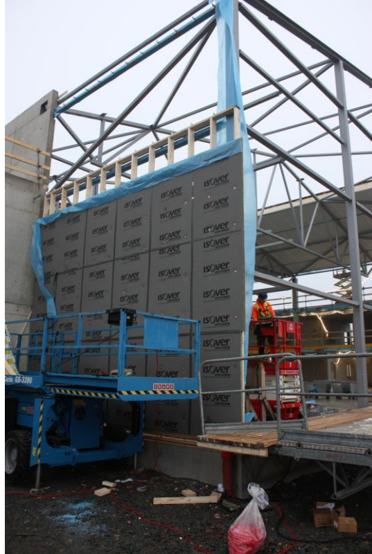
Liikuntasalin puurunkoseinä
