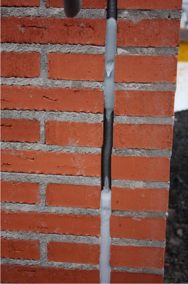
Tiilimuurauksen liikuntasaumamalli
