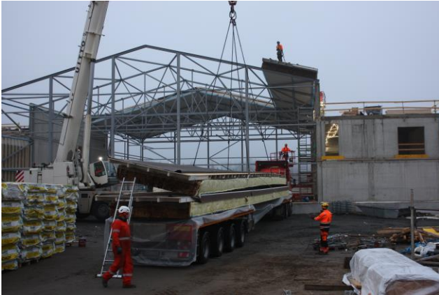
Liikuntasalin kattoelementtien asennusta
