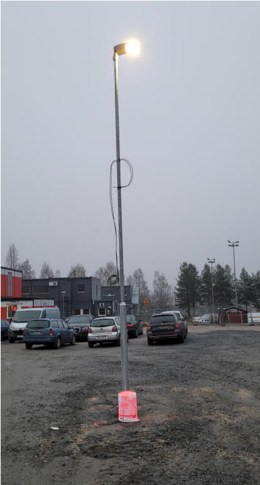
Valaisinpylväässä on varaukset valvontakameralle (roikkuvat kaapelit)
