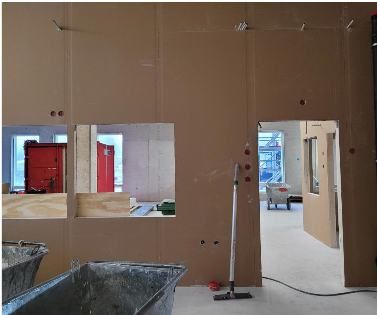
B-osalla väliseinäputkitukset hyvässä vauhdissa
