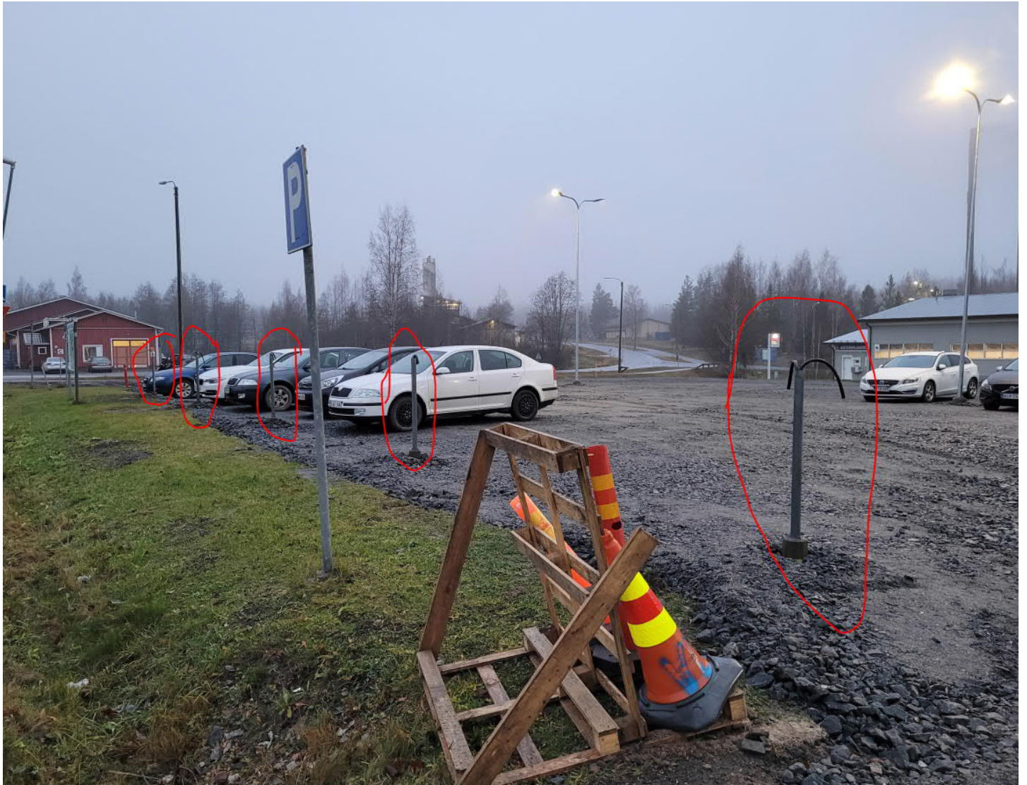
Lukion parkkipaikan lämmitystolpat. Työmaakokouksessa on päätetty että rasiat uusitaan.
