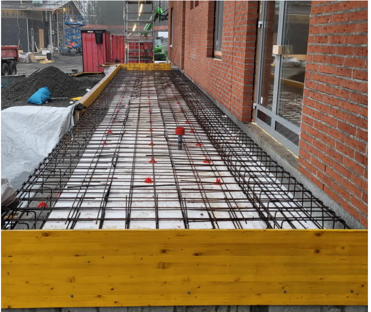
Sulanapitokaapelit vielä puuttuu
