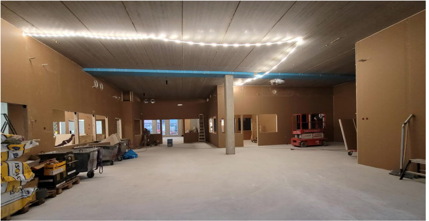
B-osalla välisenät pystyssä ja putkitettu
