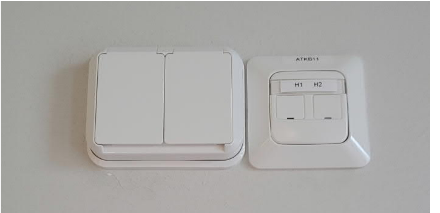
Pistorasia ja yleiskaapelointipiste B-osalla.
