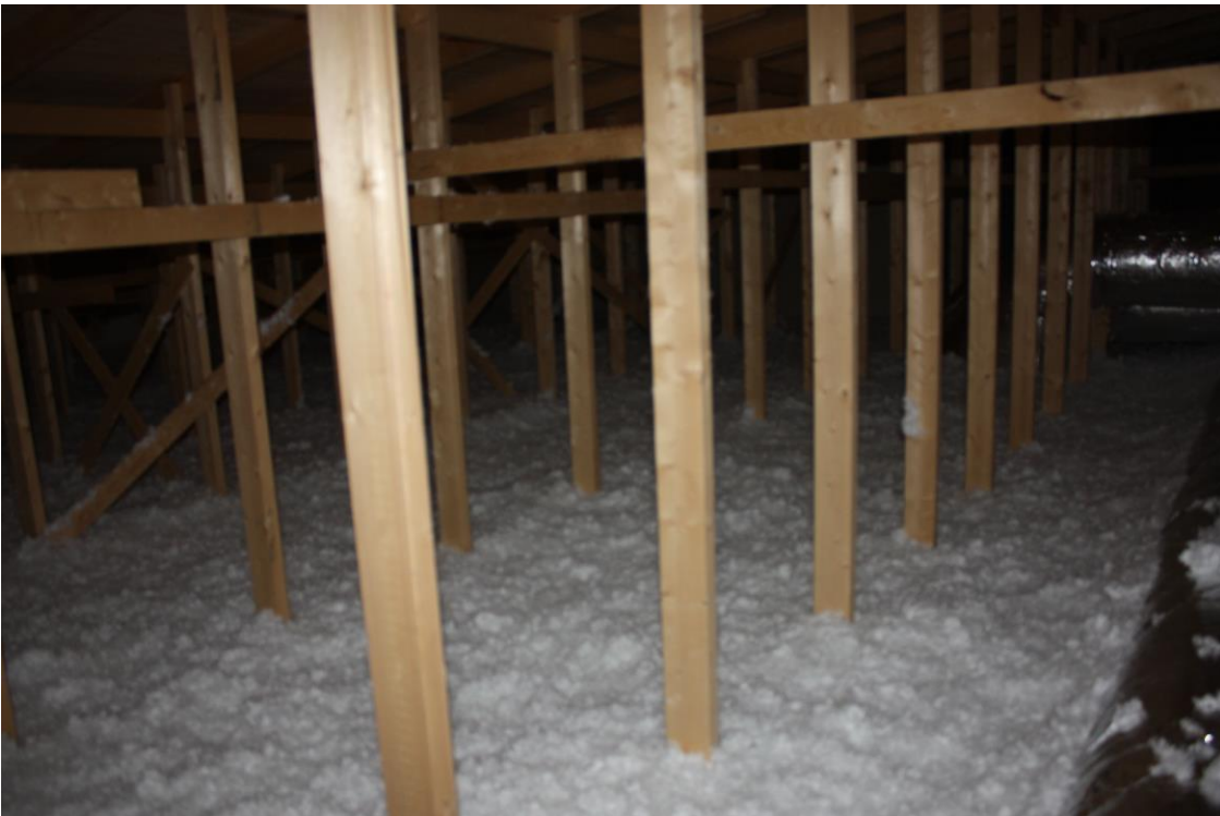
Yläpohjien eristeet yläasteella ja käsitöissä asennettu
