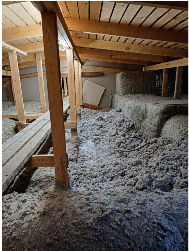
Saneerausosan yläpohjaa
