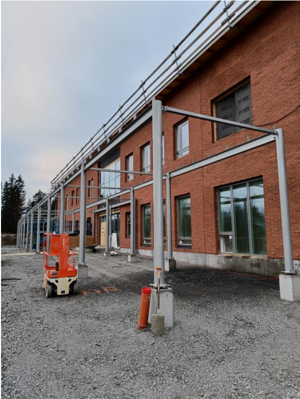
Yläasteen sivukatoksen runko
