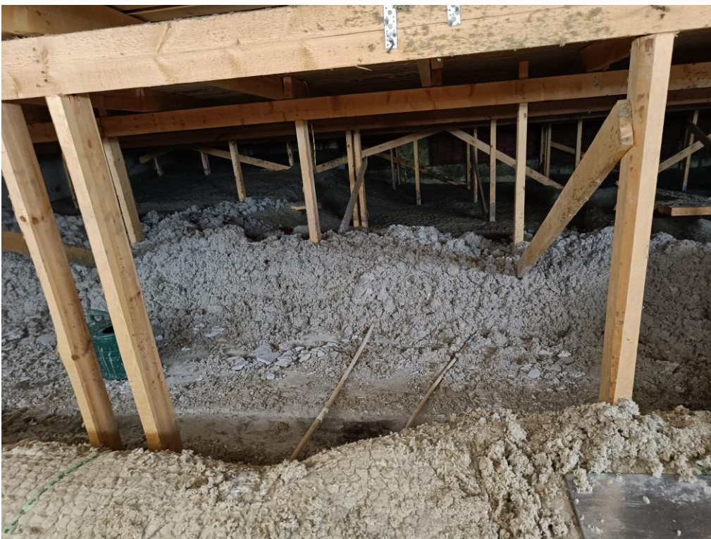
Saneerausosan yläpohjaa, deltapalkin ylälaippa otettu esille
