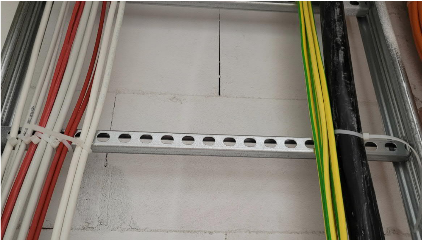
JKC21 komerossa. Onkohan nämä vielä jotain väliaikaisia kiinnikkeitä? Etenkin tuon paksun ja painava syöttökaapelin osalta tuollainen nippusidekiinnitys vaikuttaa kovin heiveröiseltä.
