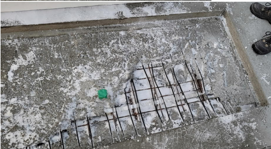
B-osan portaan ja tasanteen sulanapitokaapelointeja
