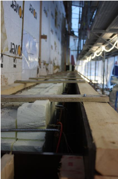
Vanhan seinän sokkelikorjaus
