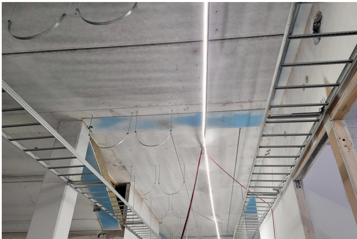
Kaapelihiyllyasennukset C-osan 1. krs käynnissä
