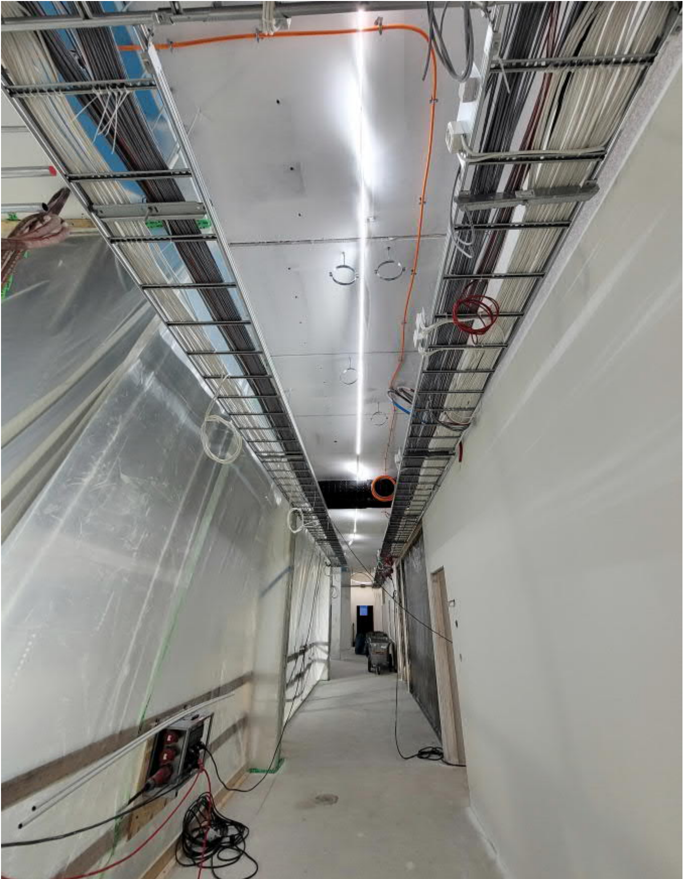
C-osa 2. krs käytävää. Johtoteiden kapasiteetti näyttäisi riittävän hyvin.
