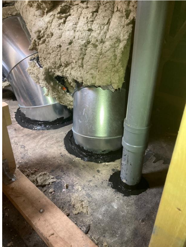
Yläasteen yläpohjan läpivientien tiivistys
