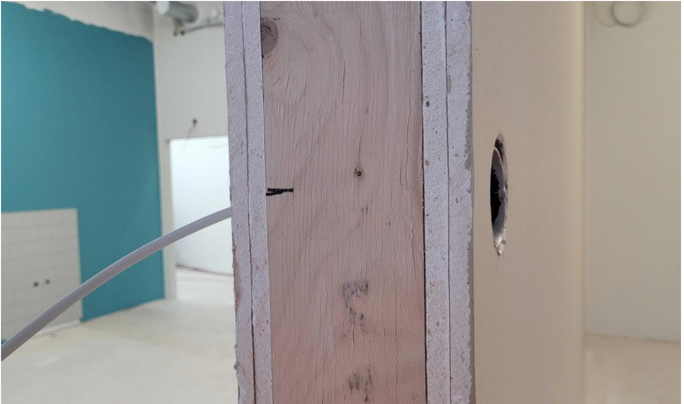
C218 ja viereisen tilan ovipielessä on RAU-laitteen kojerasiat tasan samalla kohtaa ja kaapeli seinän toiselle puolelle viety suoraan läpi rasian pohjasta toiseen. 48 dB ääneneristävyys ei taida ihan toteutua, jos rasoiden kautta on käytännössä suora reikä seinän läpi.
