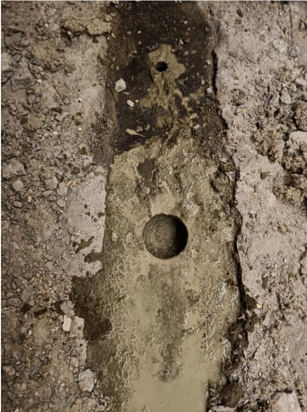
Saneerausosan vanhan deltapalkin täyttöä
