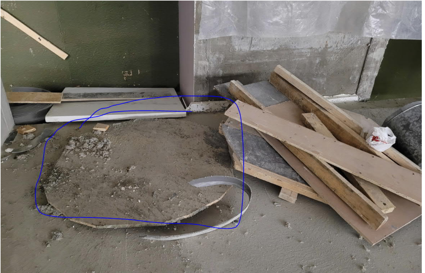
E- ja A-osien välissä oleva IV-konehuone. Tuossa levyn alla on metrinen pyöreä reikä. Levy on kyllä tukevasti, mutta aukkosuojaa ei ole merkitty aukkosuojaksi.
