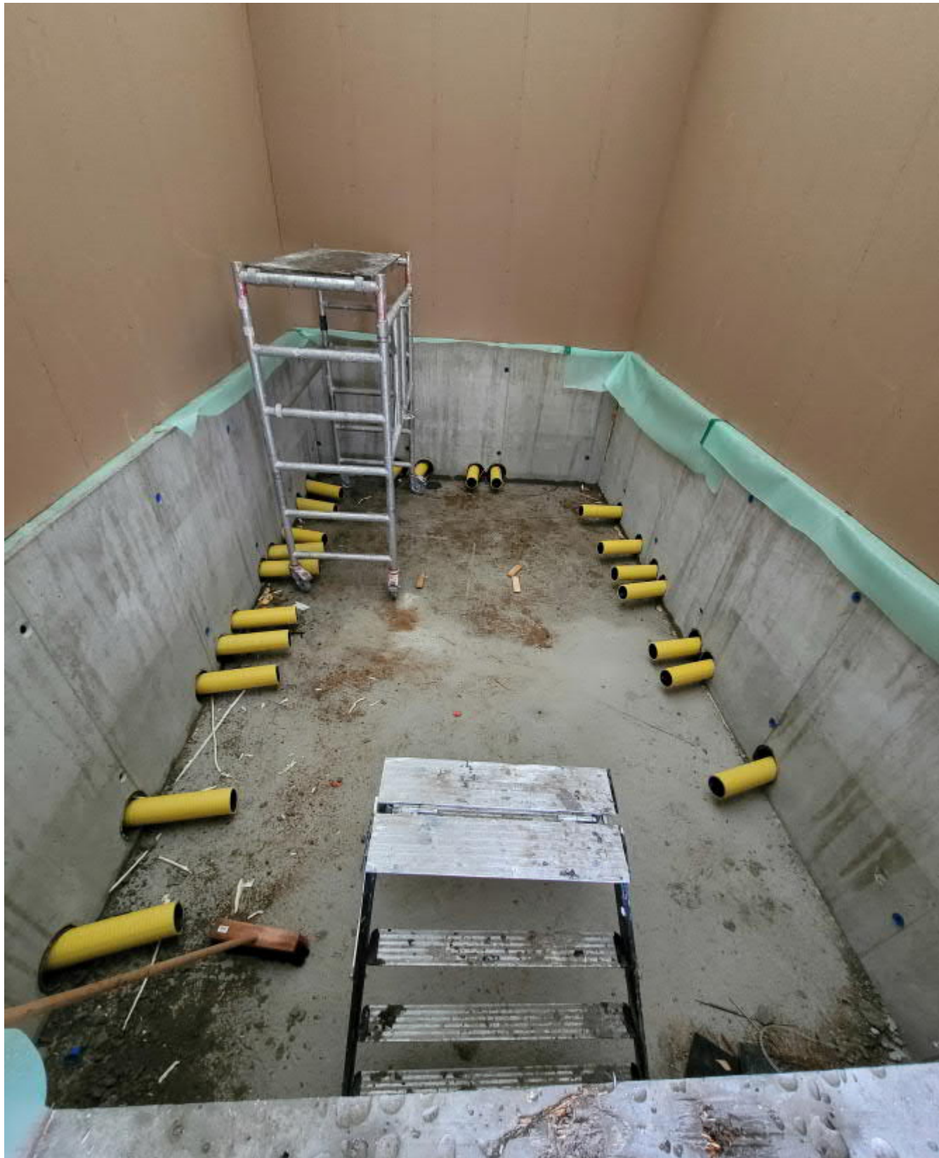
Sähköpääkeskusrakennuksen asennuslattiatila ja tulevat putkitukset.
