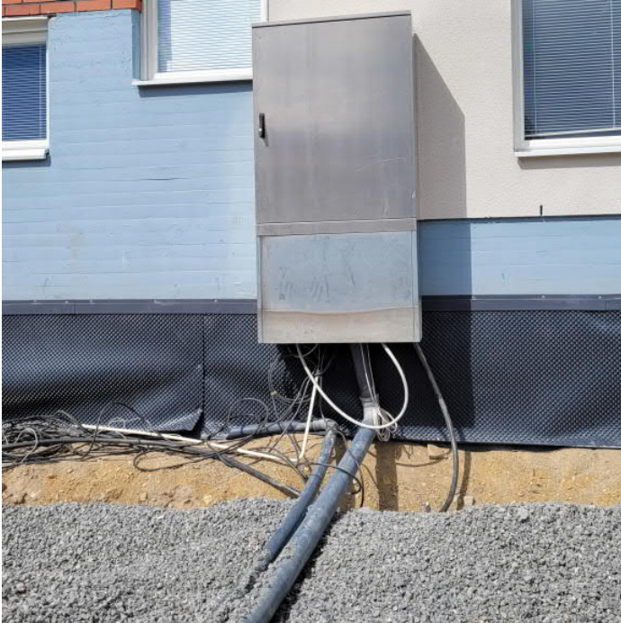
Ruokalan ja ala-asteen välisen sisäpihan jääviä asennuksia. Näitä on varottava maanrakennustoissa. Jäävät kaapelit merkittävä nauhoilla
