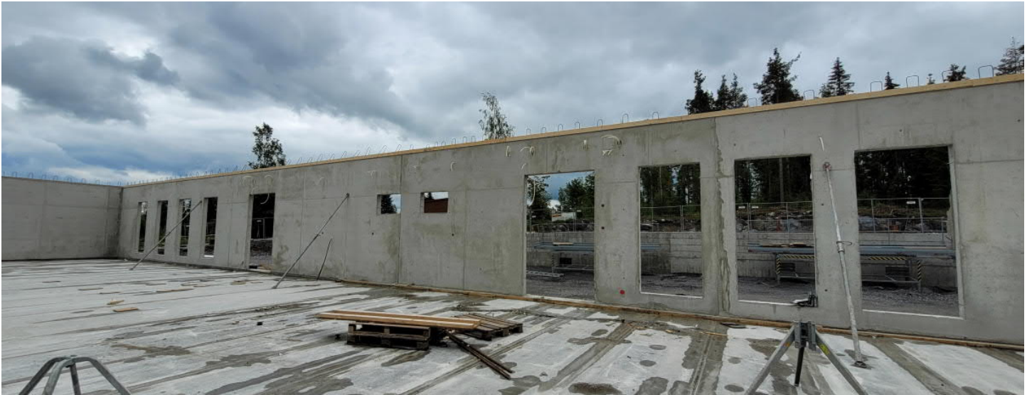
Kädentaitojen tilat. Paikallavaluseiniin tehty putkitusvaraukset.
