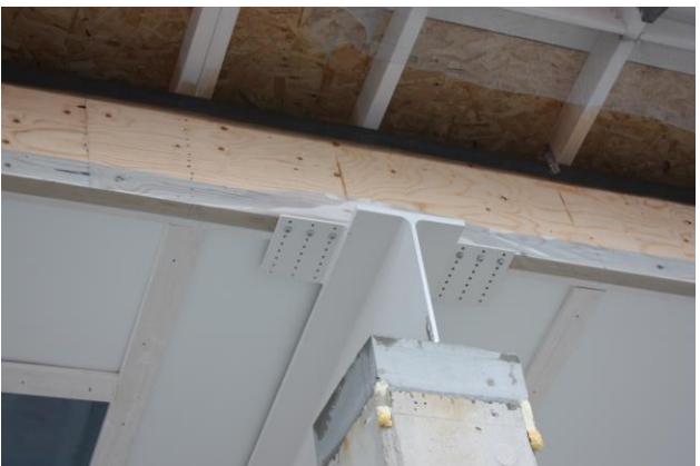
Käsityön iv-konehuoneen pilariliitos
