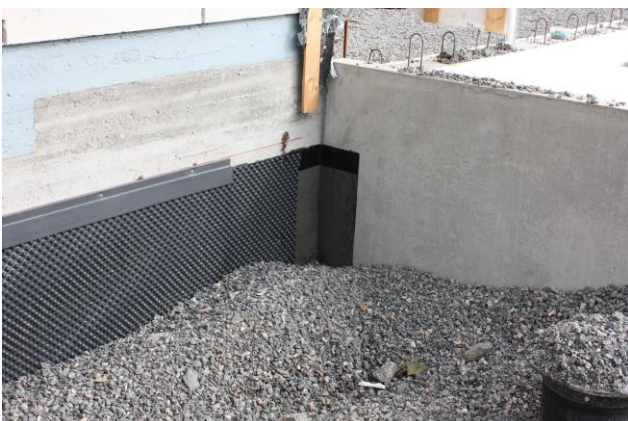
Vanhan sokkelin kosteuseristys
