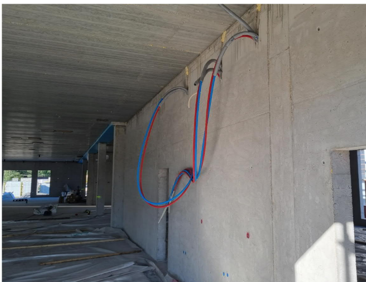
Kuva 2. Käyttöveden kalusteputket suojaputkessa seinärakenteessa.
