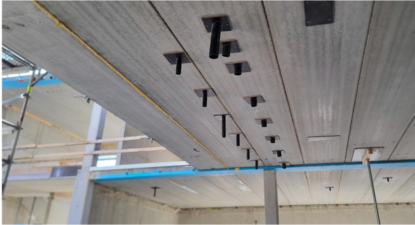
Kuva 1. Yläasteen välipohjissa viemäriläpivientejä.
