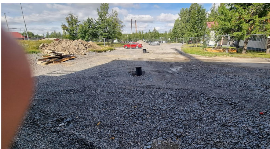
Kuva 4. Yläasteen KL-putket ja viemärilinja peitettynä.
