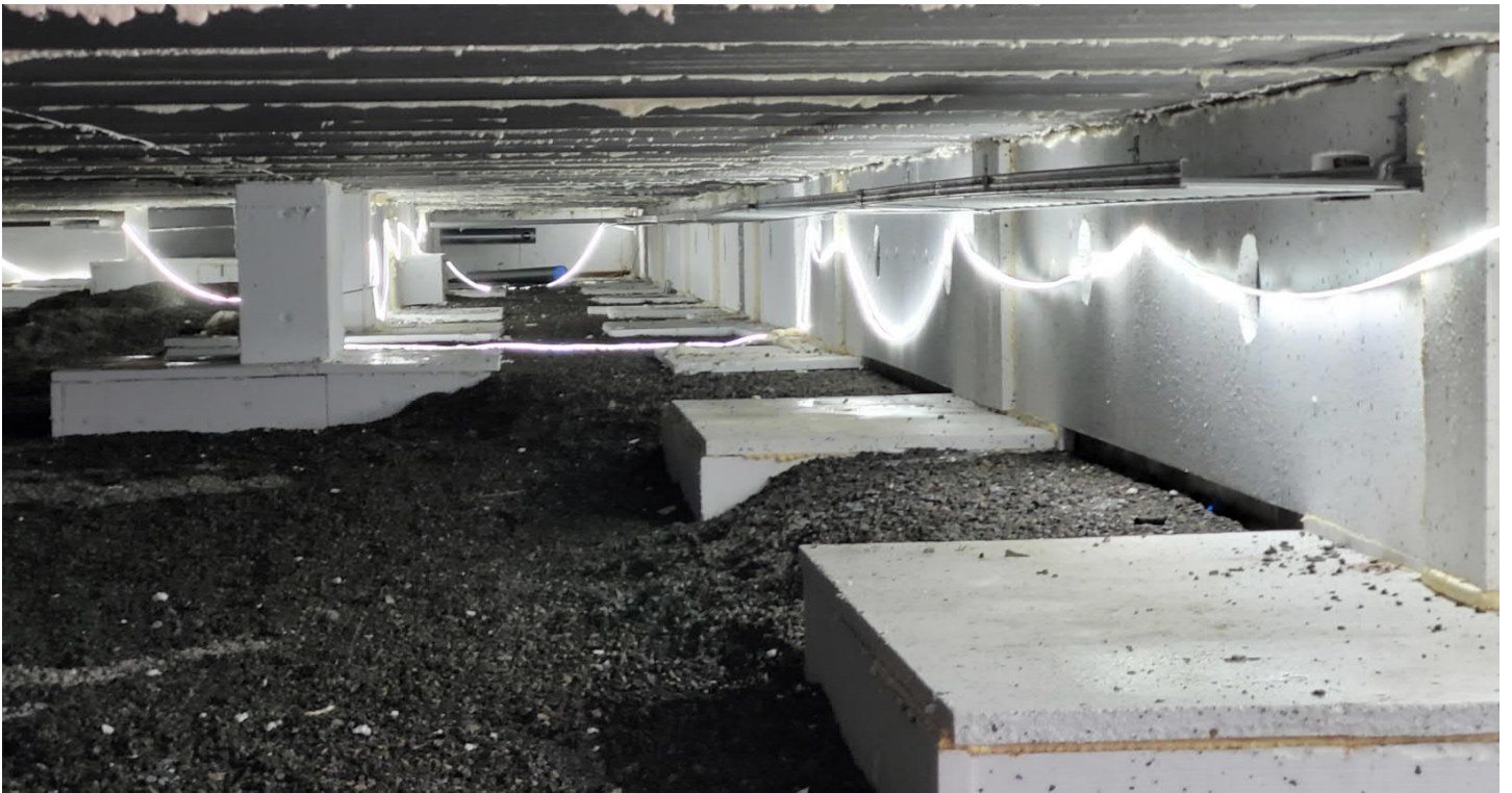
Yläkoulun alapohjassa kaapelihyllyt asennettu
