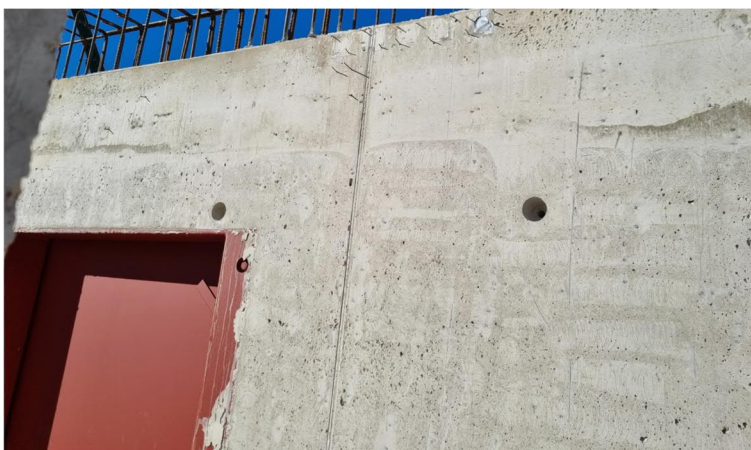
Kuva 3. VSS-tilan putkiläpiviennit kuvan yläreunassa.
