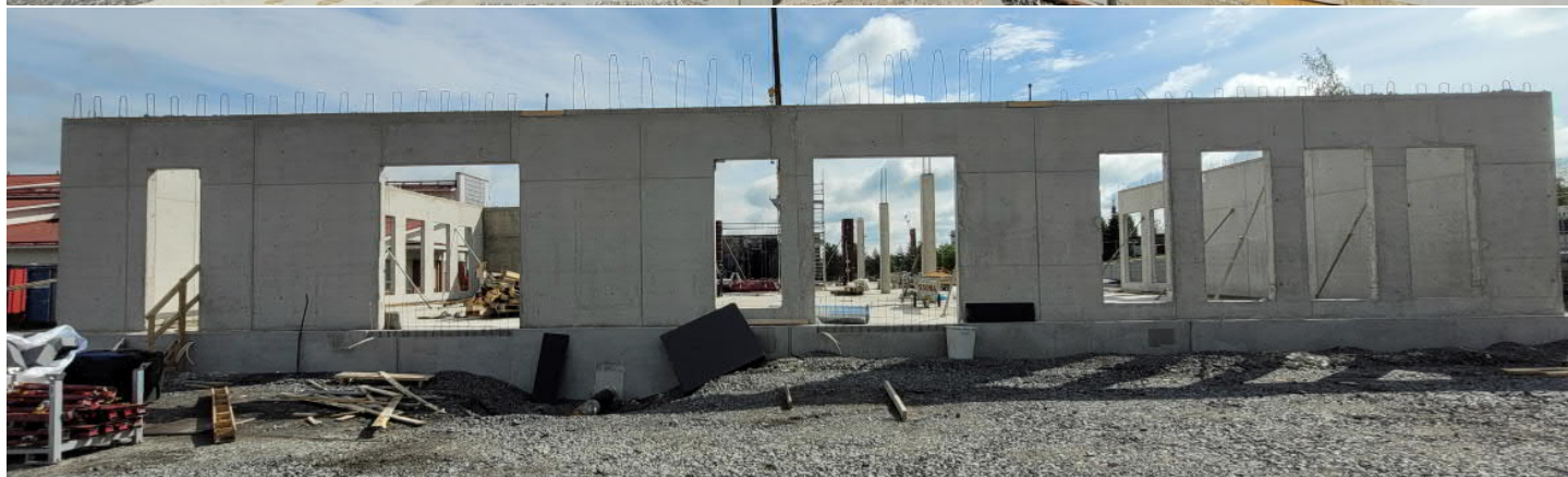
Kädentaitojen rakennuksessa alkaa paikallavaluseinät nousta
