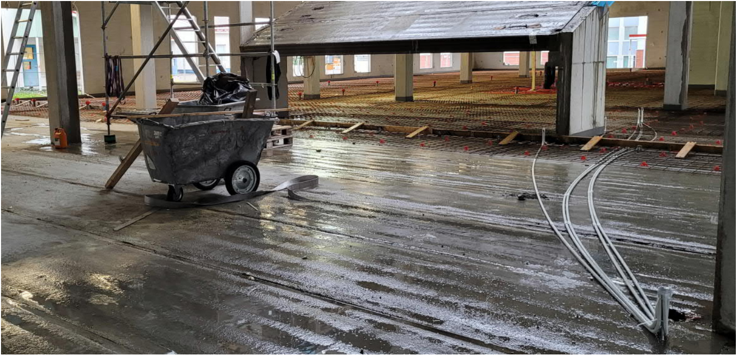
AV-kaapeloinnin putkituksia C-osalla
