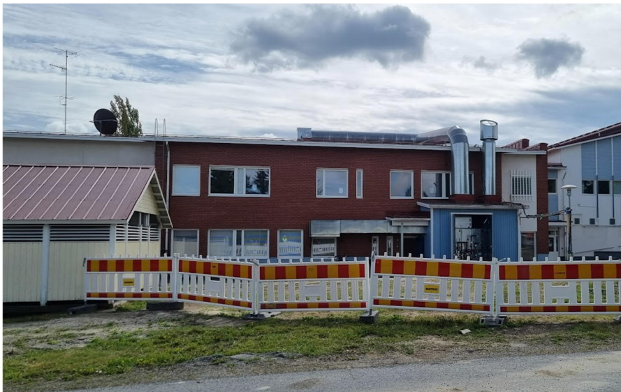
Kuva 5. Näkymä saneerausosan keittiön nykyisestä ilmanvaihdosta. IV-kone sinisessä tilassa, Tuloilma seinästä keittiöön, Poistoilma katon kautta konelle, LTO glykoli.
