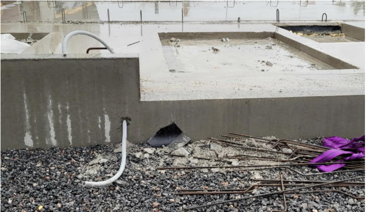
E-osalla yhden sisäänkäynnin sulanapidon putkitusvaraus
