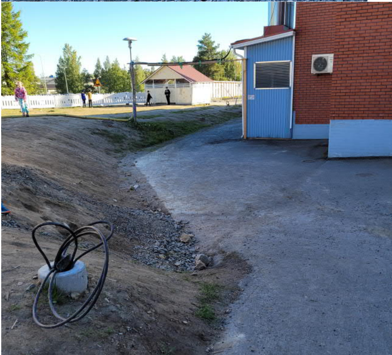
Valaisinkaapeloinnit pitkälti tehty. Kuvassa näkyy myös väliaikaisytön ventti
