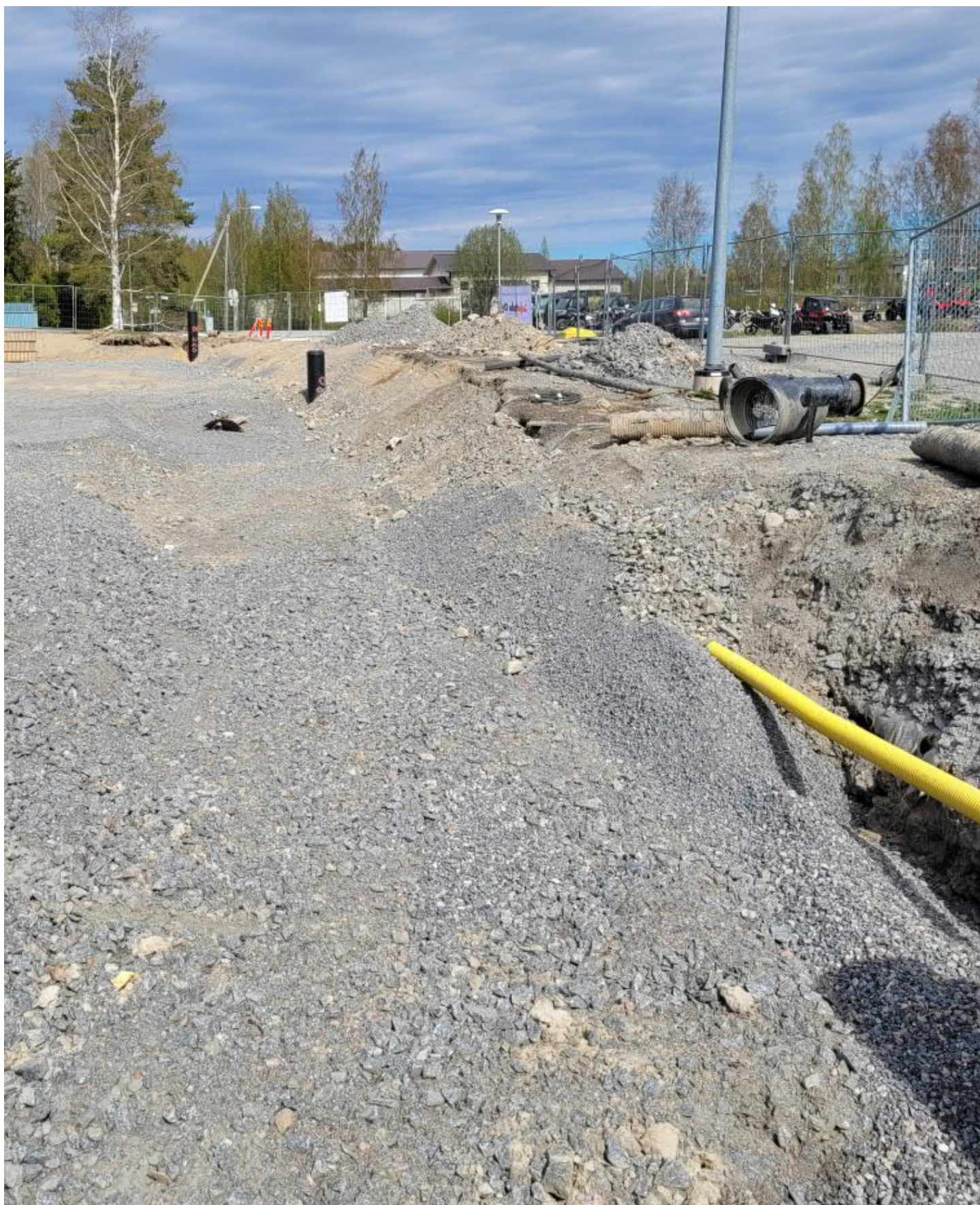
Väistötilojen liittymäkaapeli on siirretty ja suojattu
