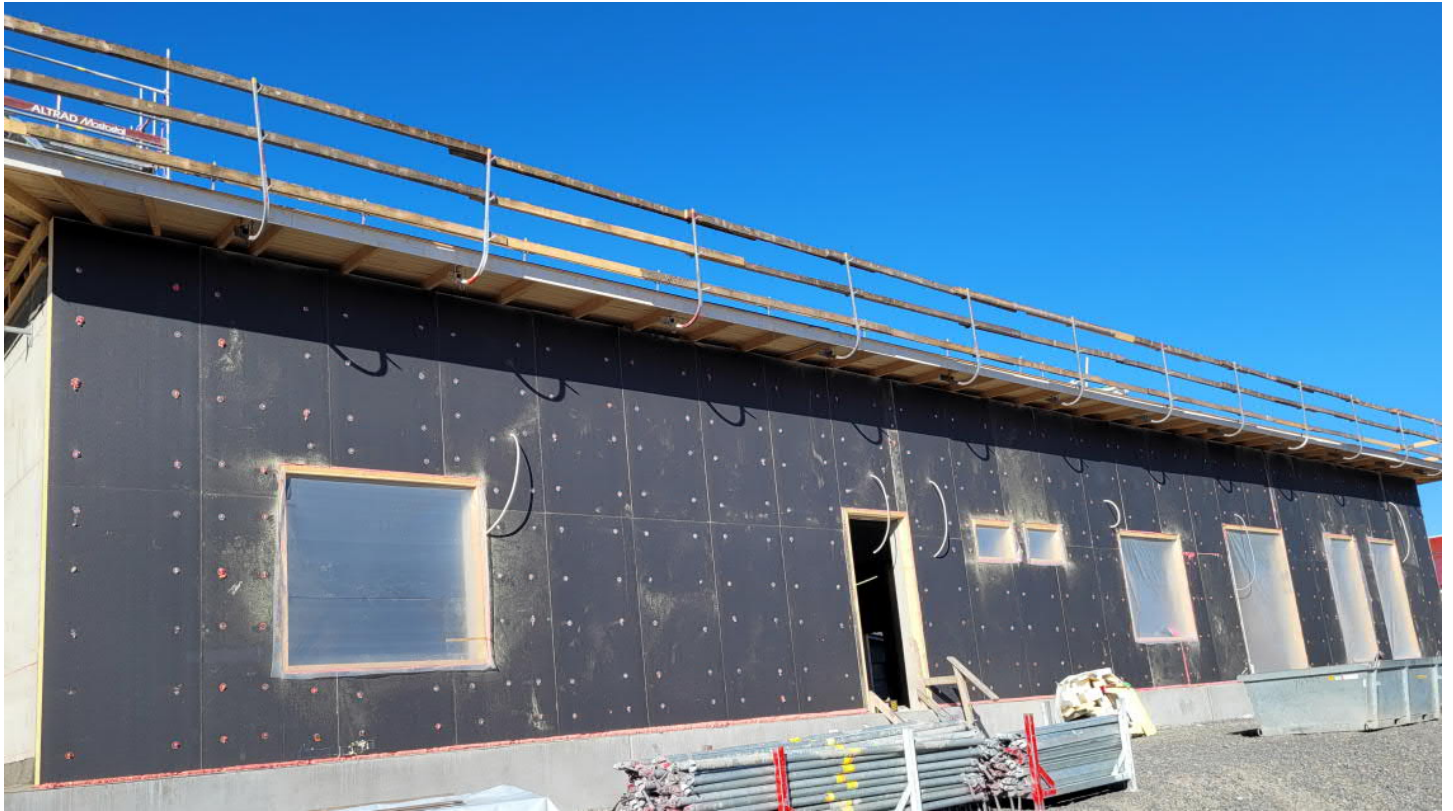
Sähkön putkivarauksia C-osan seinässä
