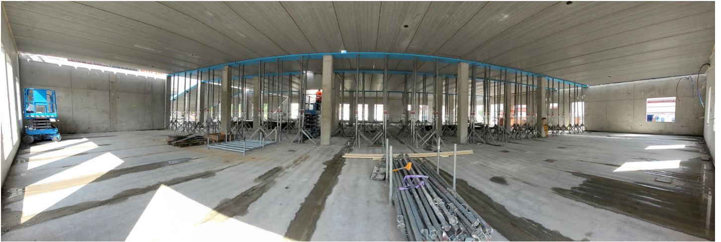
Yläkoulun 2. krs lattian ontelolaatat asennettu
