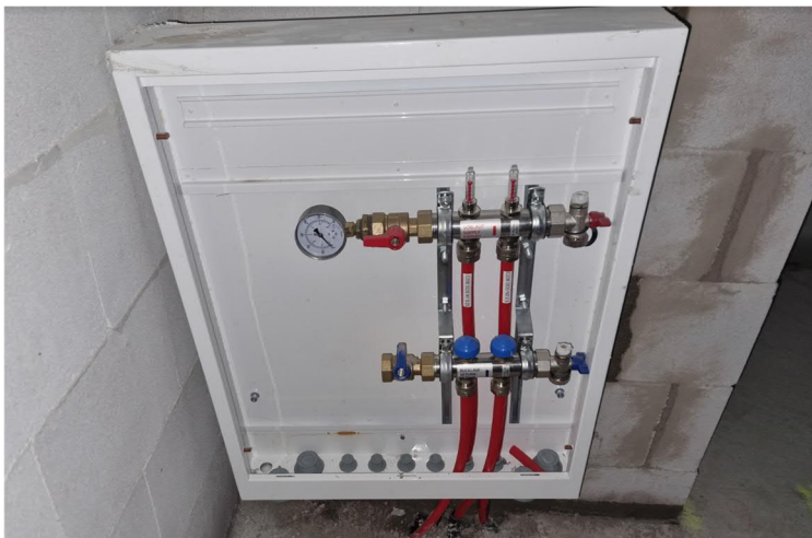
Kuva 1. Lattialämmityksen jakotukkikaappi
