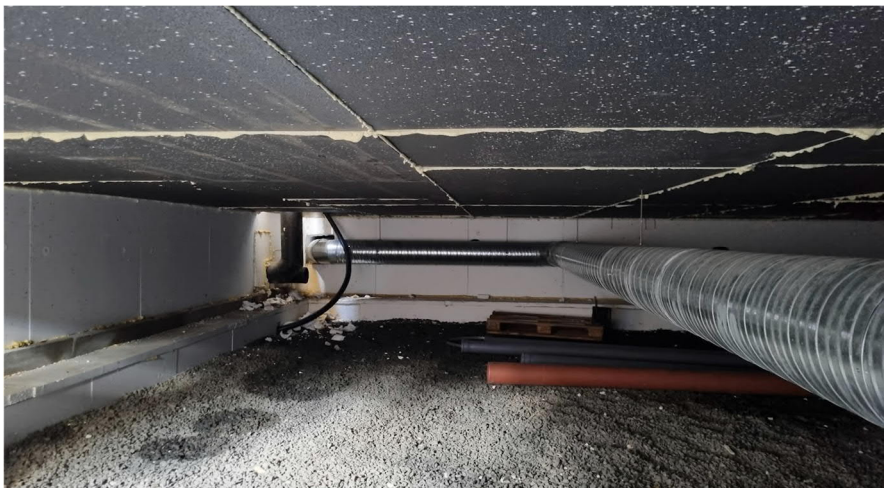
Kuva 2. Yläasteen alapohjan kanava-asennuksia. Kanavat tulpattuna.
