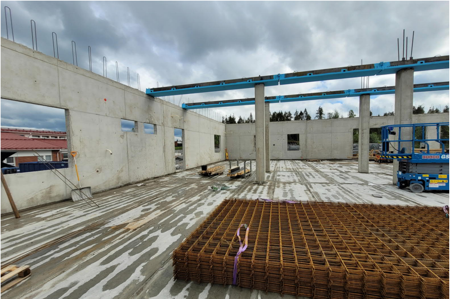
Yläkoulun 1. krs paikallavaluseinät on tehty ja niihin varattu sähkösuunnitelmien mukaiset putkitukset ja rasiat
