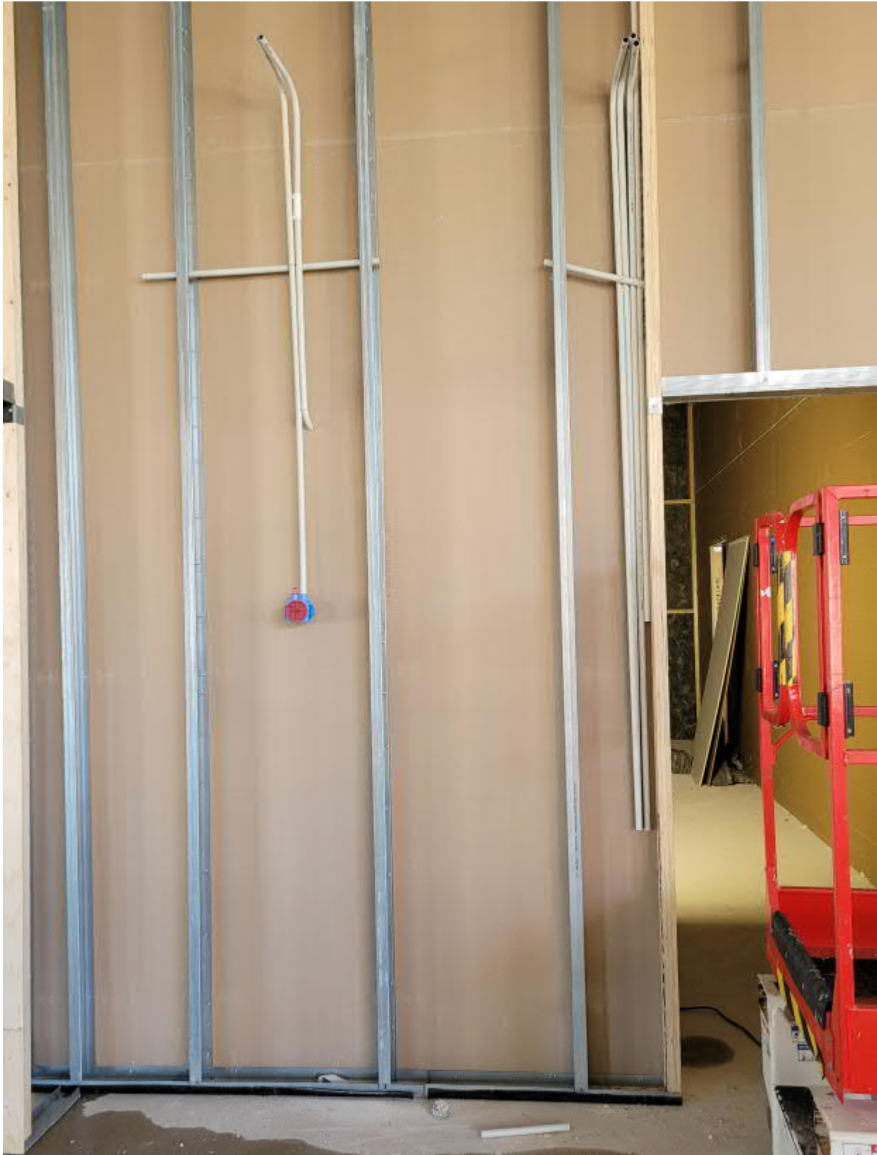
C-osan. 2. kerroksessa väliseinätyöt vauhdissa.
