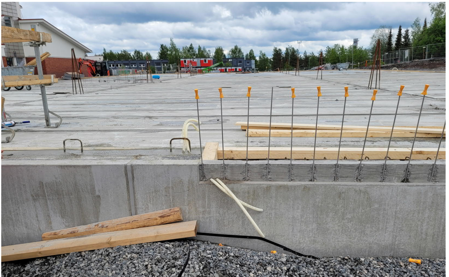
Käsityötilat. Sisäänkäyntien sulanapitolämmityksille on varattu läpivientiputkitukset.
