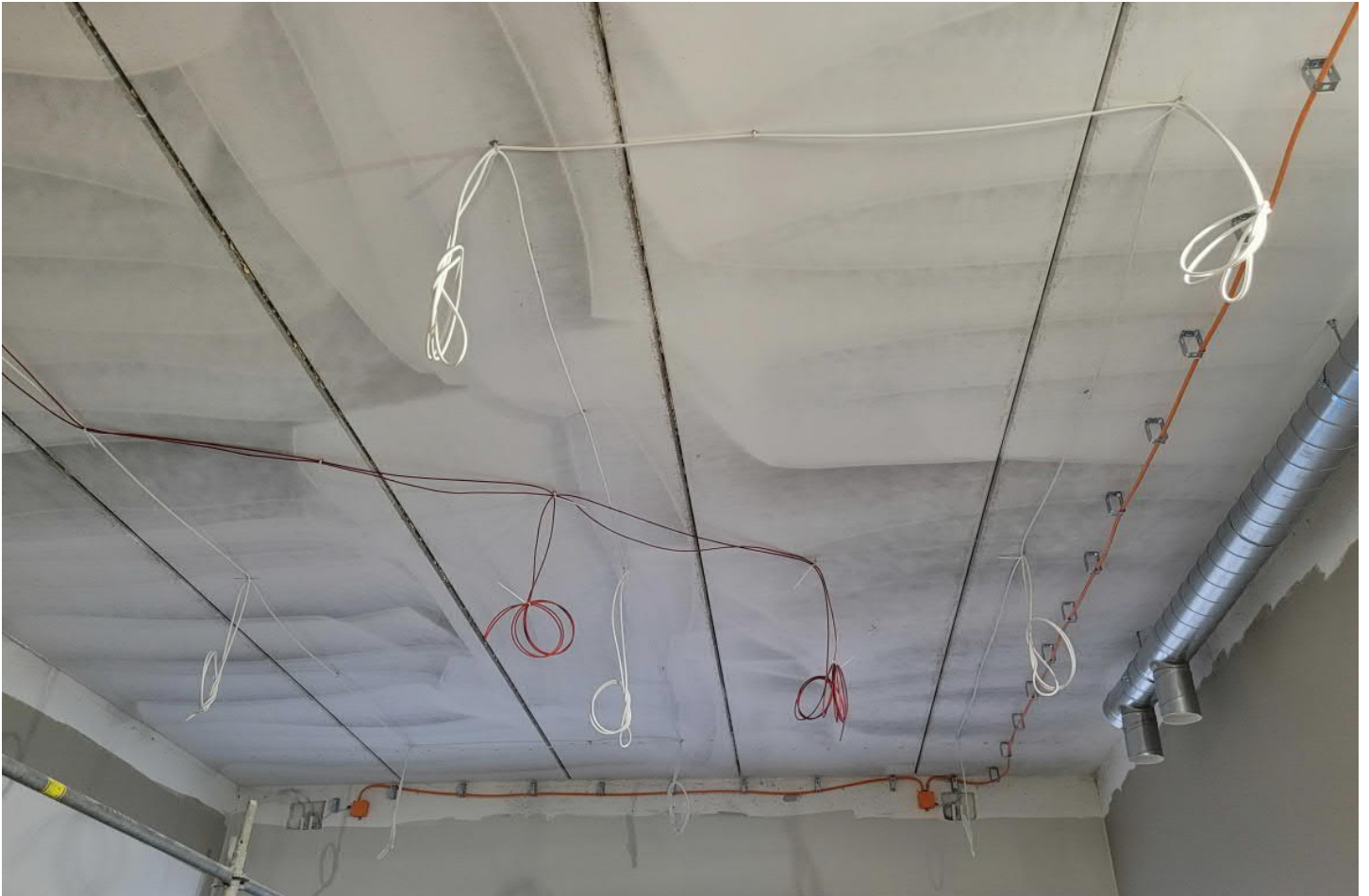
Kaapelointeja C-osan pääsisäänkäynnin korkean portaan katossa
