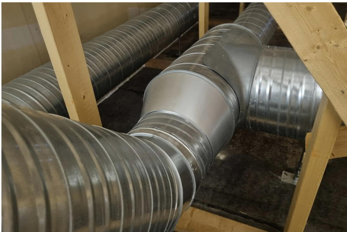
Kuva 6. Kädentaitojen ullakolla vielä osittain kanavat ruuvein -> vaadittu niittikiinnitys!
