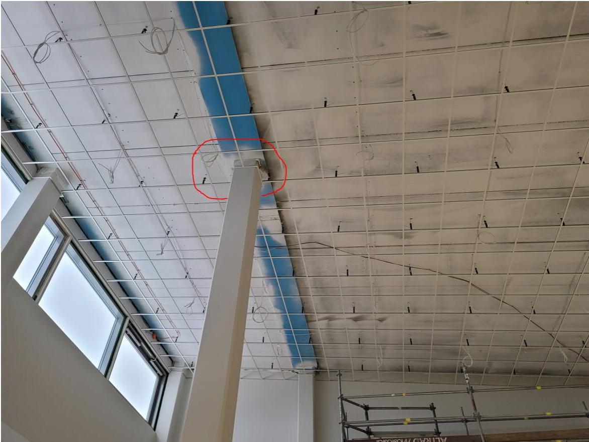
Valaisinta ei voi asentaa ruutuun jossa on pylväs. Jätetään valaisin pois, jos suunnittelijan valaistuskalkelmalla voidaan osoittaa, että se ei liikaa pilaa valaistusta
