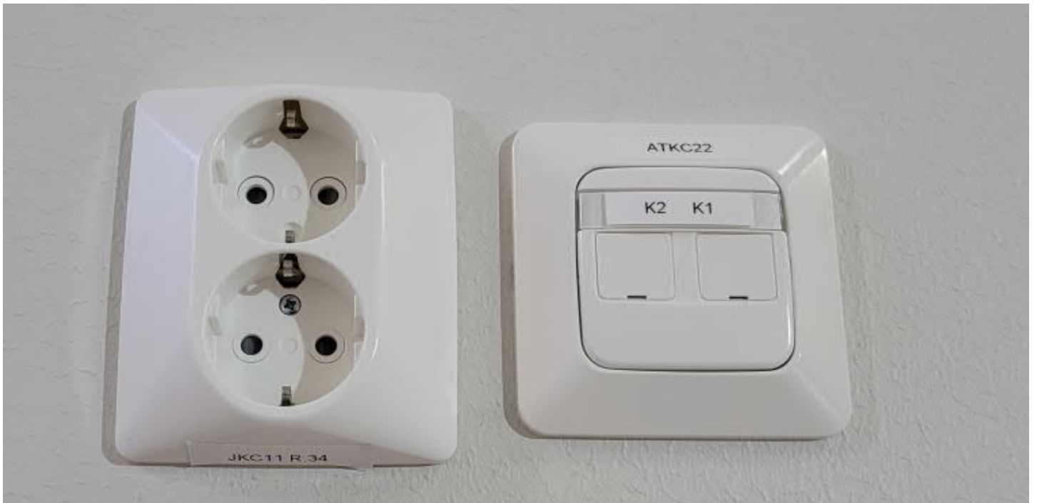
Seinään tulevissa yleiskaapelointirasiossa on vaaditut pölyläpät-
