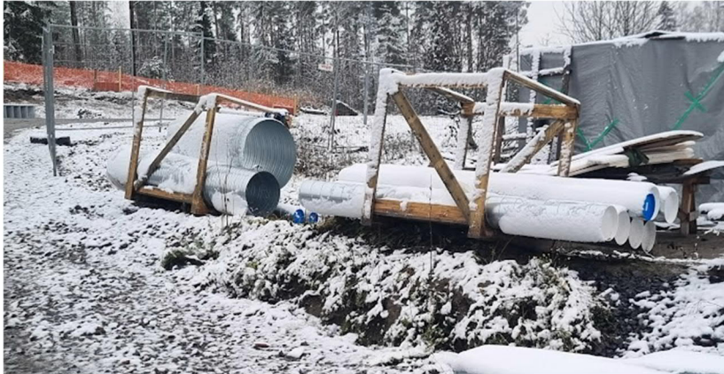
Kuva 1. IV-kanavia piha-alueella. Sääsuojaus?
