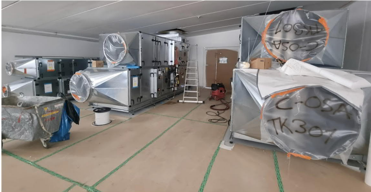
Kuva 4. Yläasteella IV-koneet suojattuina.
