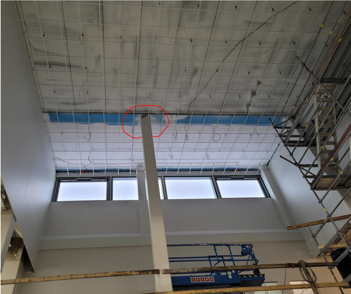
Valaisinta ei voi asentaa ruutuun jossa on pylväs. Jätetään valaisin pois, jos suunnittelijan valaistuskalkelmalla voidaan osoittaa, että se ei liikaa pilaa valaistusta
