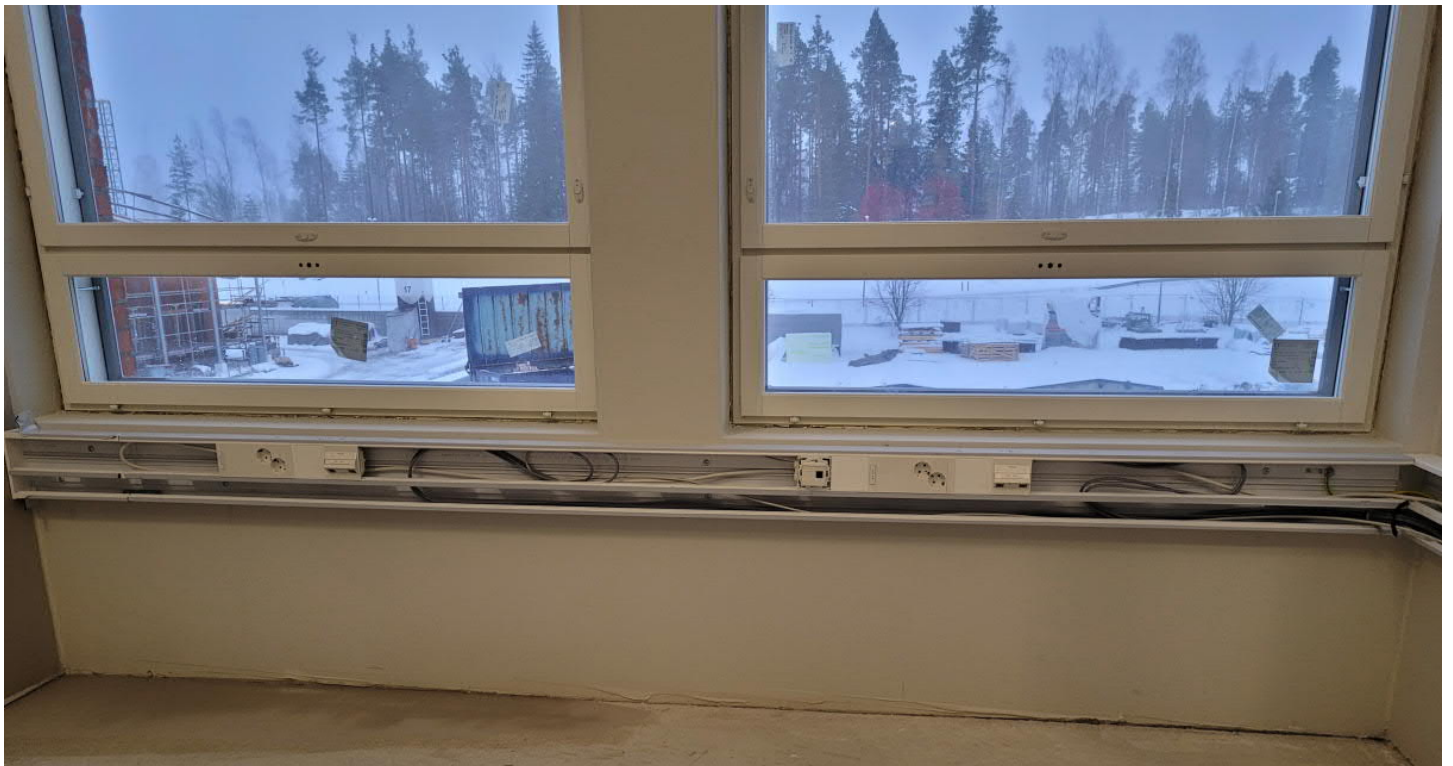
Kouruasennukset on pitkällä C-osan 2. kerroksessa
