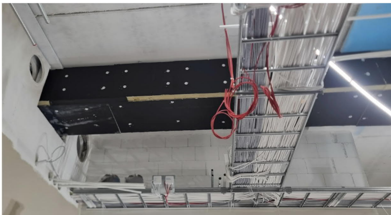
Kuvat 8 ja 9. Yläasteen kotitalousluokkien rasvaeristystä aloitettu.
