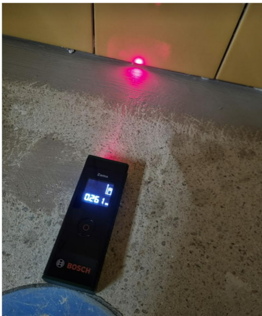
Kuva 1. Yläasteen 1.kerroksen wc-tiloissa lattiakaivo jää melko kauas seinästä. Pesualtaan kytkentäviemärin olisi syytä jäädä selvästi pesualtaan syvyysmitan sisäpuolelle, että lattian päällä kulkeva kytkentäviemäri ei olisi altis käytönaikaisille vaurioille.
