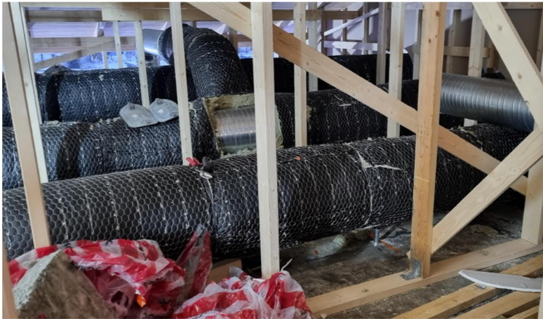
Kuva 6 ja 7. Liikuntahallin ullakon kanavointeja. Paloeristys Paroc HVAC Firemat BlackCoat tuotteella. Kanaviin aloitettu puhdistusluukkujen liisäykset.
