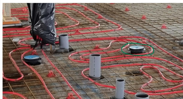
Kuvat 3 ja 4. Yläasteen 1.kerroksen wc-tiloissa lattiakaivo jää melko kauas seinästä.
