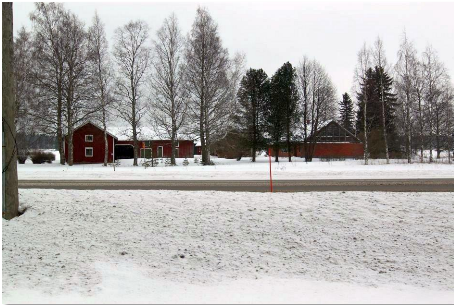
Kuva 9 Maatilan päärakennus ja pihapiri osoitteessa Kaskistentie 84. Päärakennus on puilitoistakerroksinen tiilirakennus 1970-80 luvulta. Puurakenteiset ulkorakennukset ovat 1900 luvun alkupuoliskolta.
