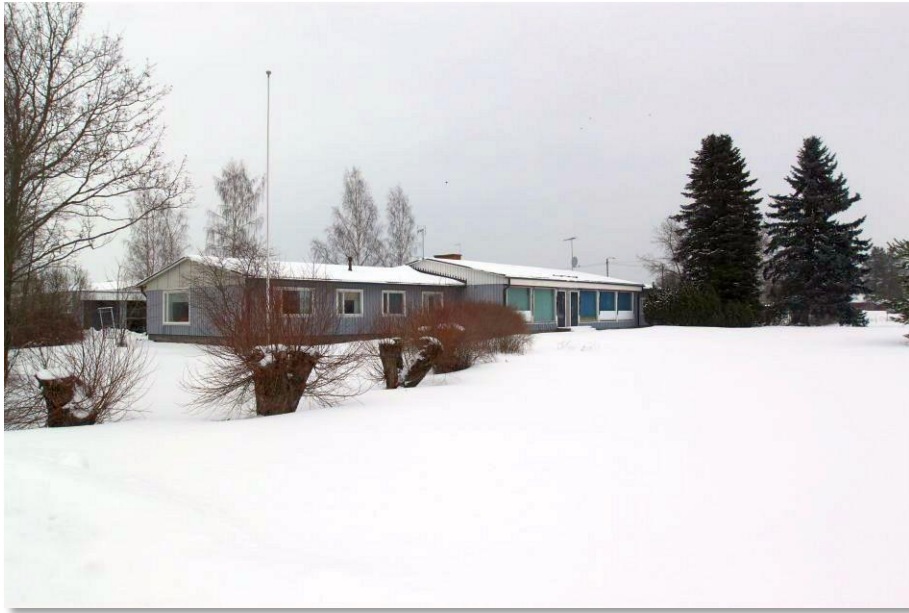
Kuva 10 Rakennus osoitteessa Käälytie 5. Puurakenteinen yksikerroksinen rakennus on toiminut liiketilana sekä asuinrakennuksena.
