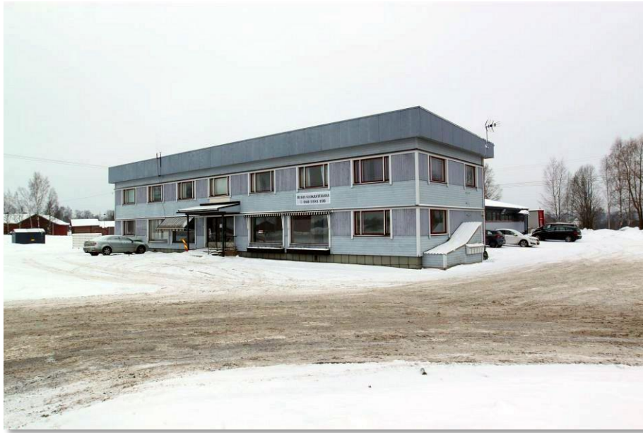
Kuva 8 Rakennus osoitteessa Kaskistentie 69. Rakennusta on laajennettu halliosalla 1990 alkupuolella.
